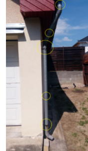
4.sz. ábra: Csapadékvíz-csatorna és lehetséges gyenge pontjai Forrás: saját kép
