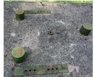
23. ábra: A pillér felső síkján kiképzett műszerfelfogószerelvények és pontjel (2021-ben fotózta a szerző)
