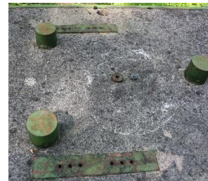
23. ábra: A pillér felső síkján kiképzett műszerfelfogószervevények és pontjel (2021-ben fotózta a szerző)
